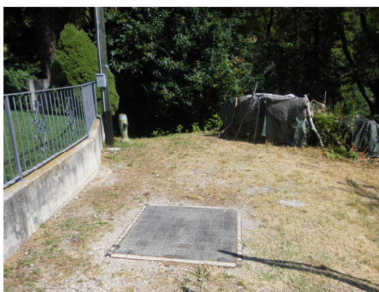
Foto 2: Lampione stradale e idrante da spostare.
