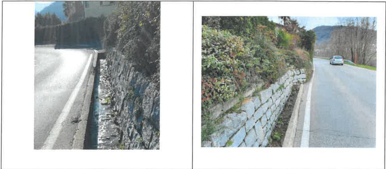
Figura 6a Canale acque meteoriche esistente
