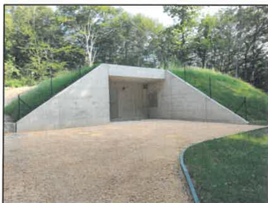
Serbatoio Morèla – 350 m3
