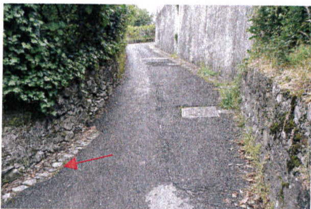
Figura 7 - Cunetta laterale esistente (pt. 20)
