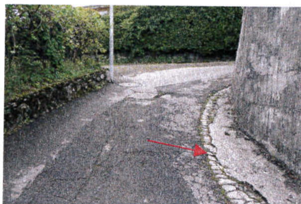
Figura 8 - Cunetta laterale esistente (pt. 21)
