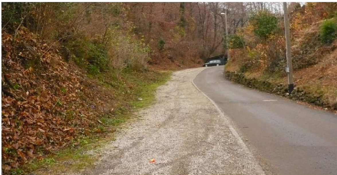
Figura 6: vista del parcheggio esistente lungo via Paladina da ampliare di circa 1.50 m
