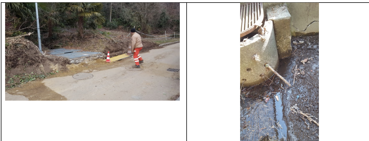
Fig 2 Camera Trema ( esterno e interno)
