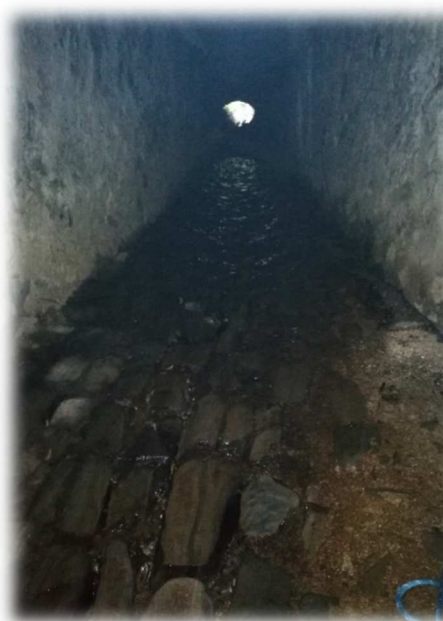
Figura 13 – primo tratto pavimentato p=53\%
