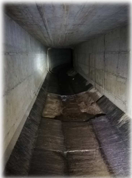
Figura 7 – Prima tratta riale, con lastricazione del fondo
