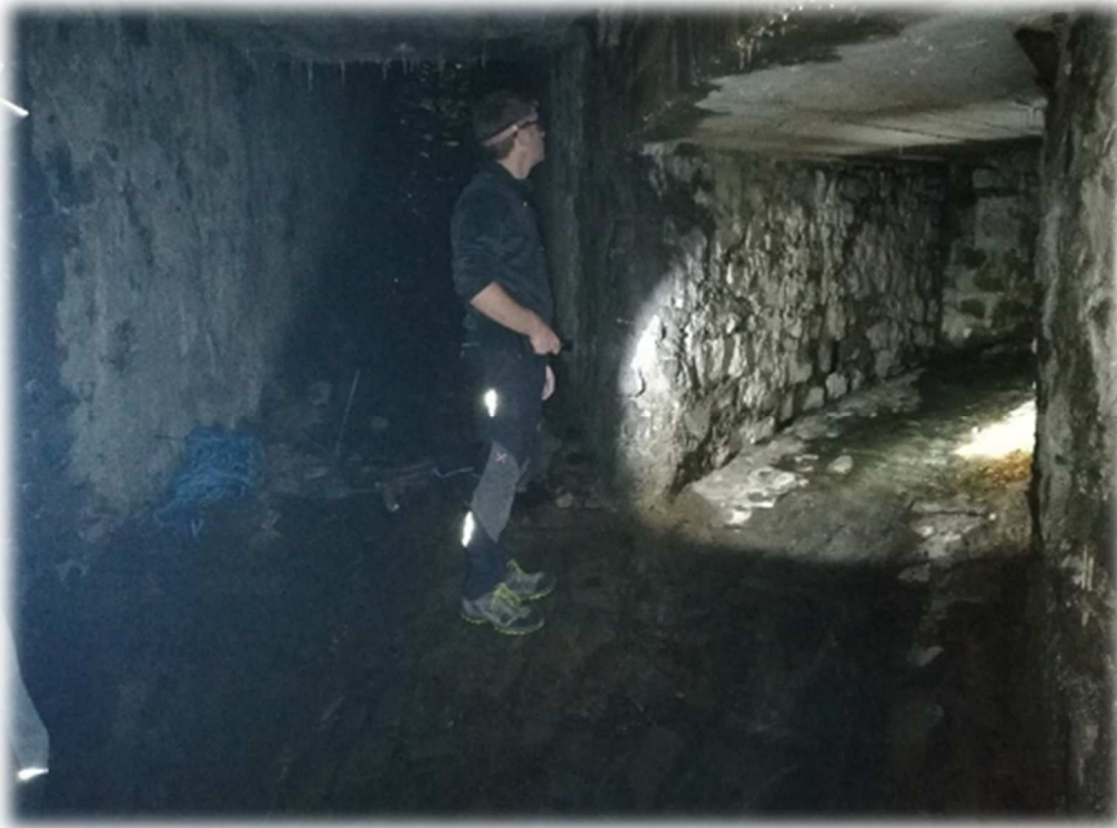
Figura 14 – Immissione scarico canalizzazione acque meteoriche strada cantonale
