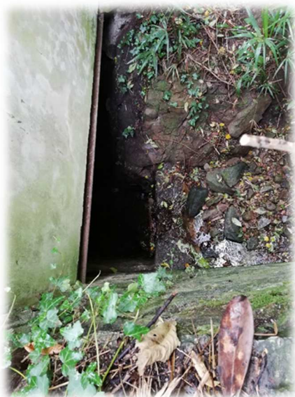
Figura 10 – Accesso sotto servizi pubblici
