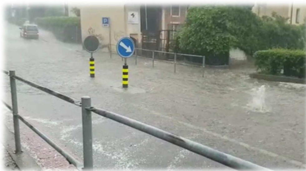
Figura 1 - Allagamenti della strada cantonale in prossimità del piazzale Gèsora
