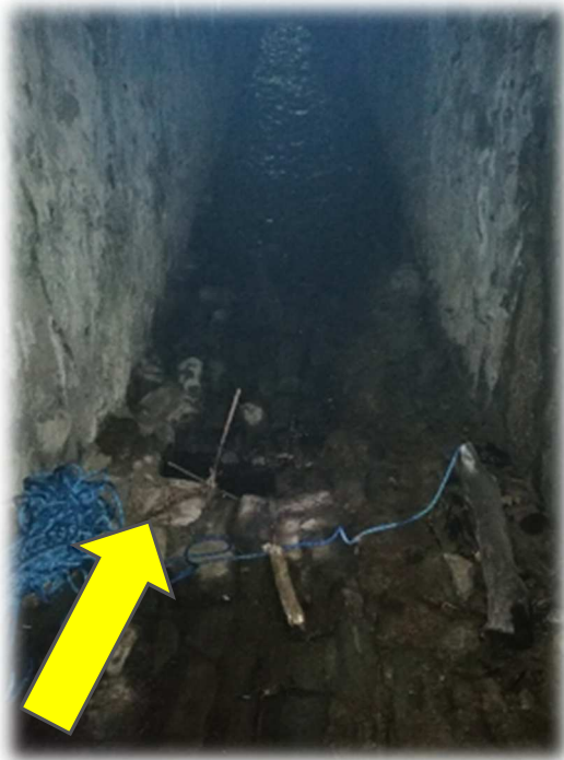
Figura 17 – Rottura fondo
