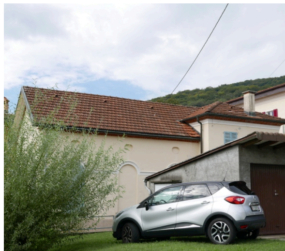
Il tetto visto da nord-est
