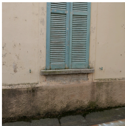
Vista dello zoccolo e dello stato delle gelosie
