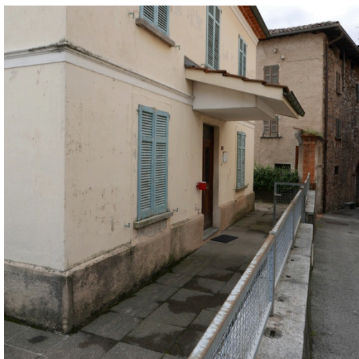
Vista della facciata nord, con la pensilina posticcia
