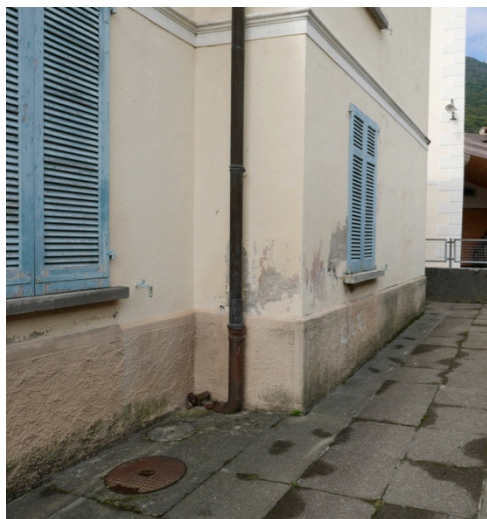
La situazione delle pareti esterne
