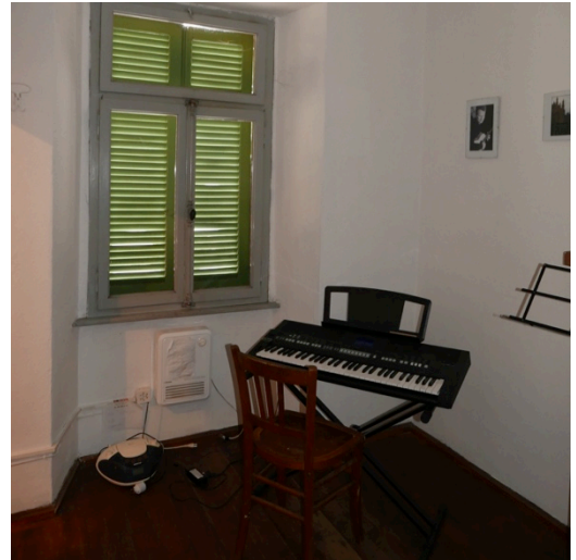
Un radiatore elettrico diretto al primo piano
