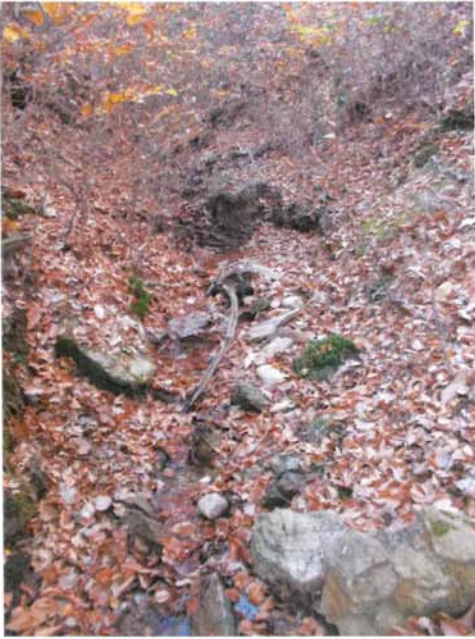
FOTO 13 – Tratto di riale con sponde poco incise nella coltre detritica.
