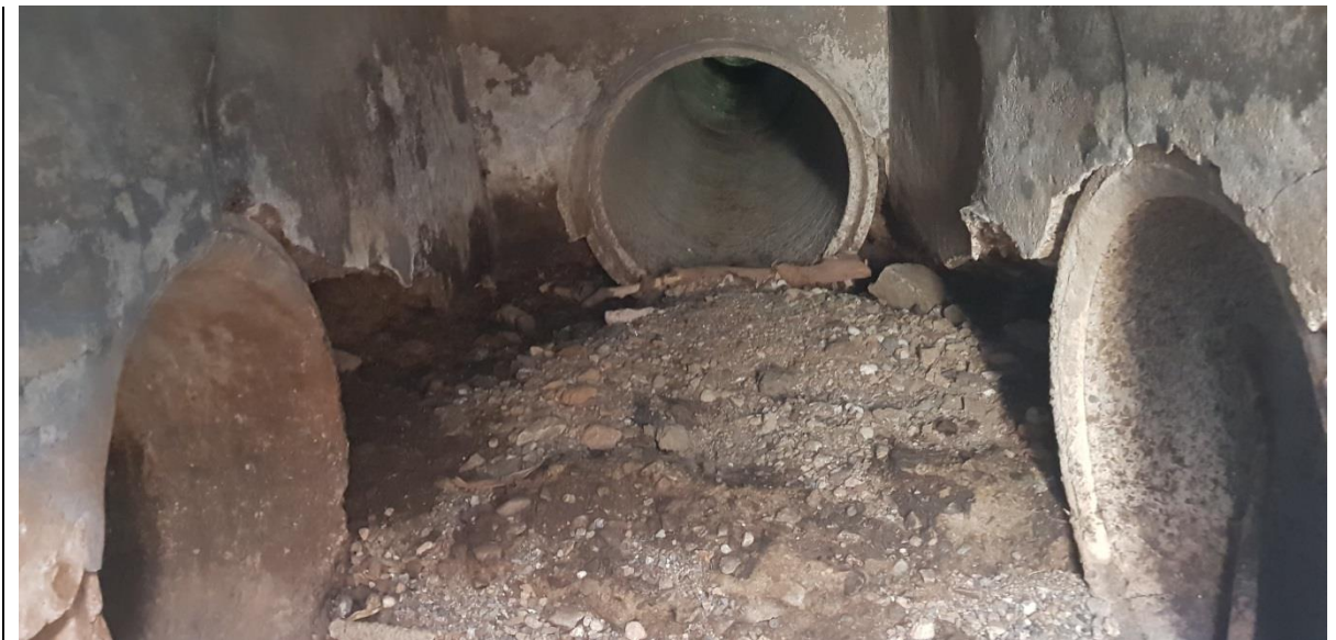
Figura 11 Fotografia interno camera M4 sotto la strada cantonale
