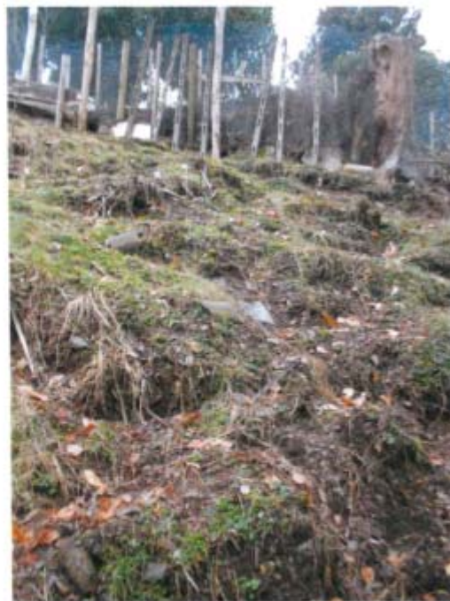
FOTO 8 – Sponda destra del riale in testata. È presente un'estesa zona instabile in detrito che potrebbe facilmente staccarsi e finire nell'alveo del corso d'acqua.
