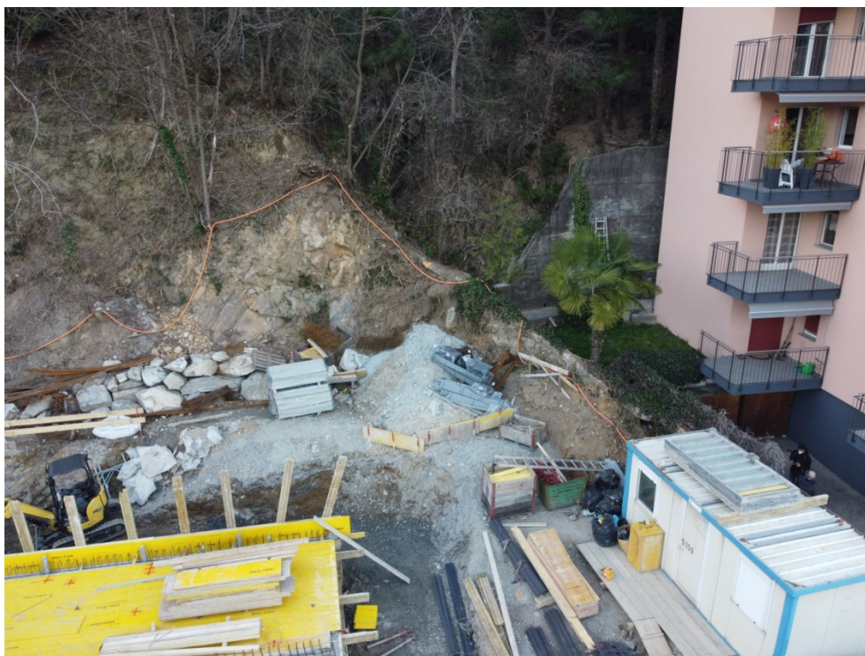
Figura 1 Cantiere nappale 1144 con a lato imbocco riale Prelongo 2
