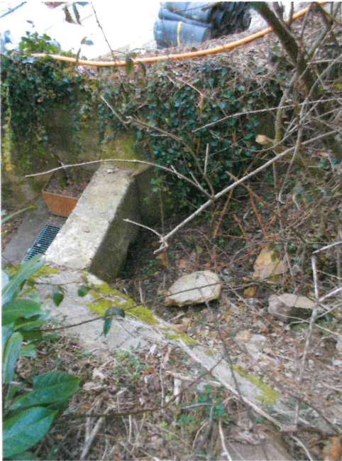
FOTO 1 – Camera di raccolta posta a monte del tratto finale intubato.
