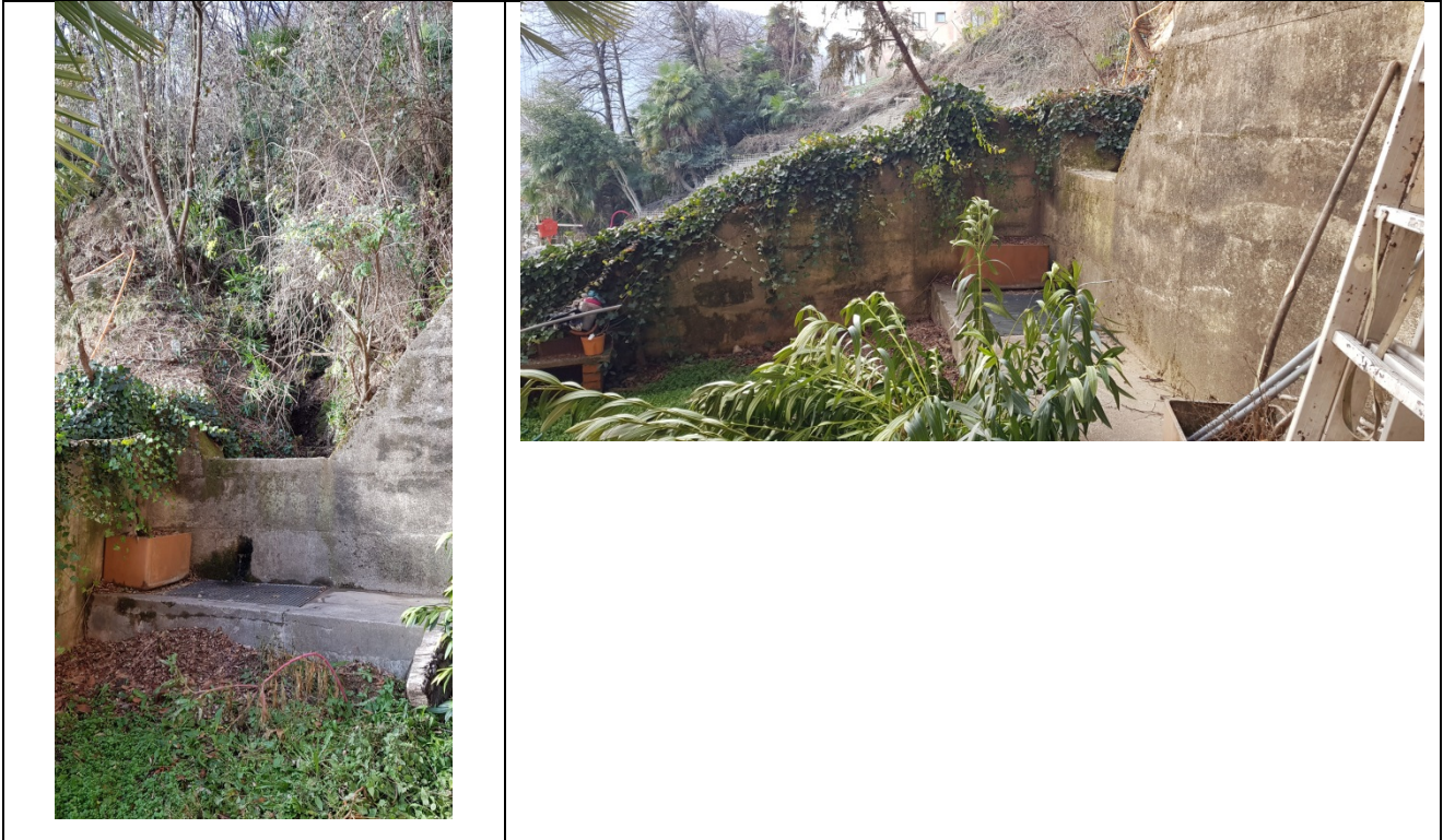
Figura 7 Camera –imbocco esistente
