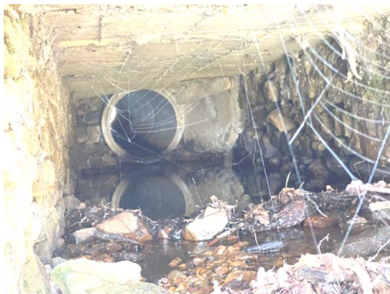
Figura 4 Foto raccordo canale rettangolare con tubo DN 600 mm
