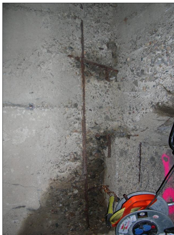
Foto 30: d19 – Vista del ferro d'armatura lungo l'elevazione.
