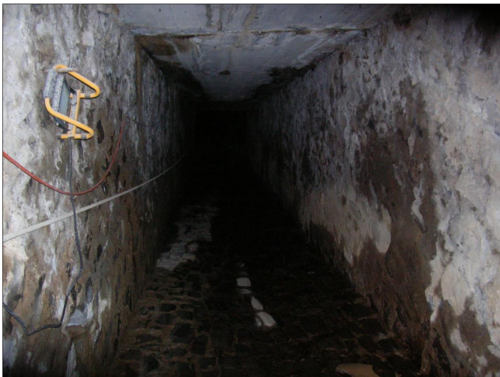
Foto 2: Vista del canale in direzione est.
