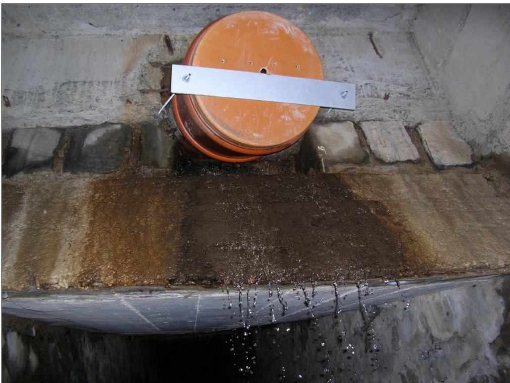
Foto 28: d19 – Probabile rottura del tubo in PVC.
