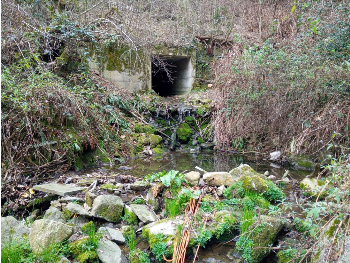
Figura 8: vista dello sbocco del cunicolo, con in evidenza il salto di quota e la pozza.
