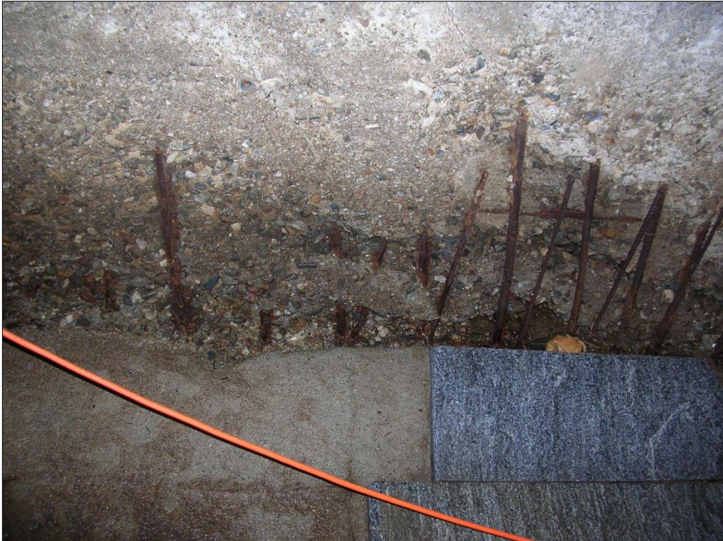
Foto 35: d21 – Vista del ferro d'armatura in elevazione.
