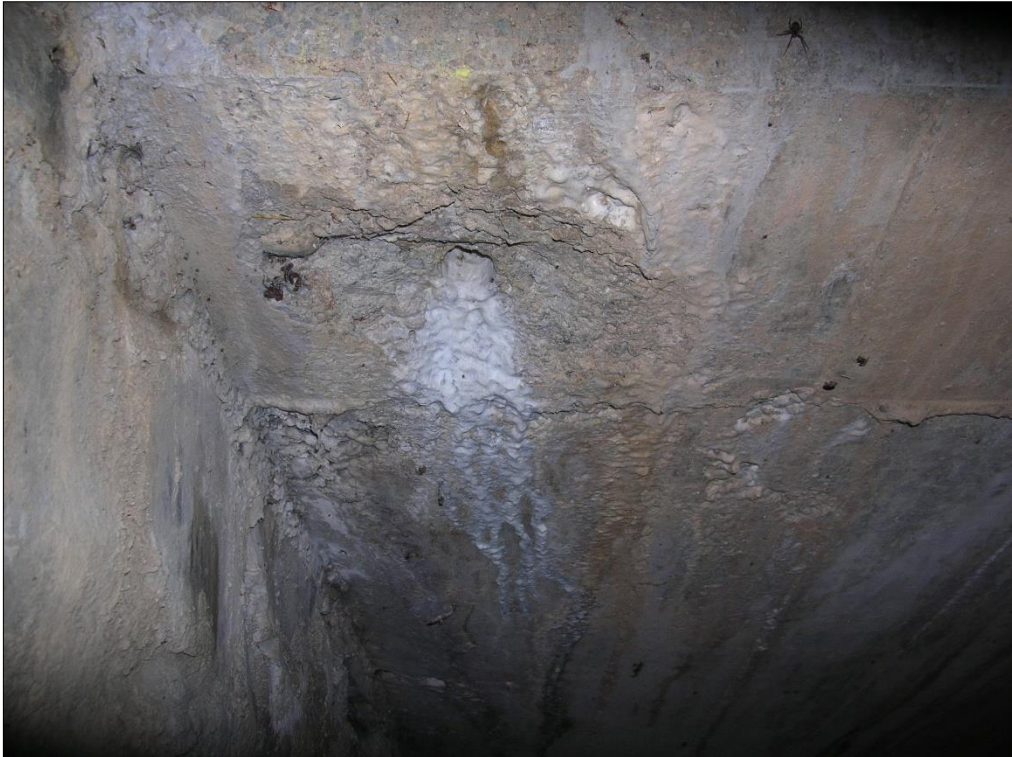
Foto 5: d2/d3 – Rottura e presenza d'umidità sul filo soletta.
