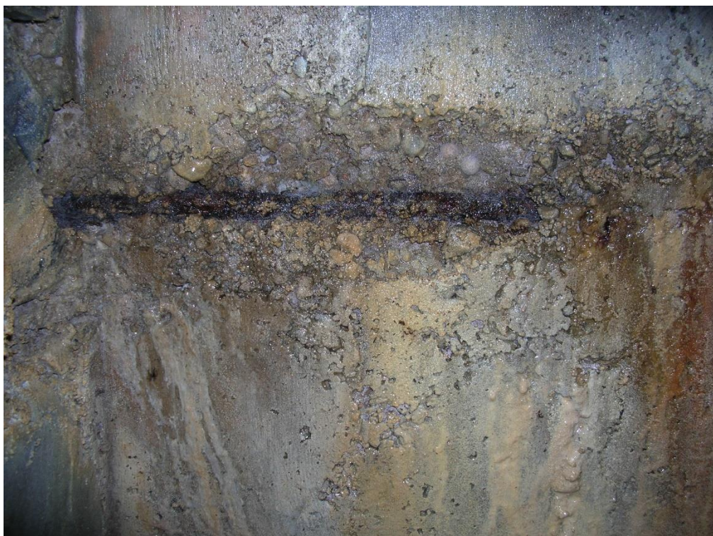
Foto 10: d6 – Rottura orizzontale sul filo soletta.
