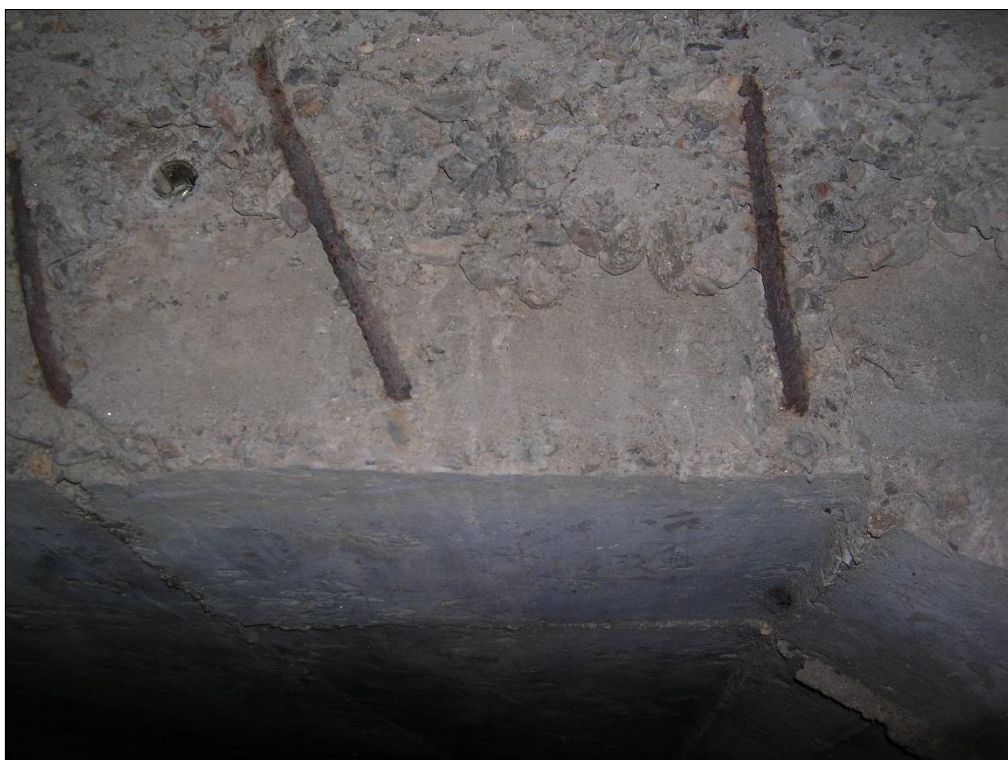
Foto 32: d19 – Dettaglio foto n°30.
