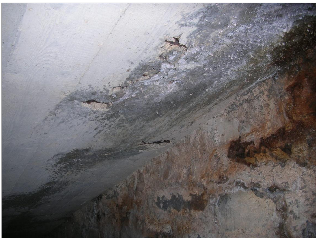
Foto 22: d16 – Rotture sul filo soletta.
