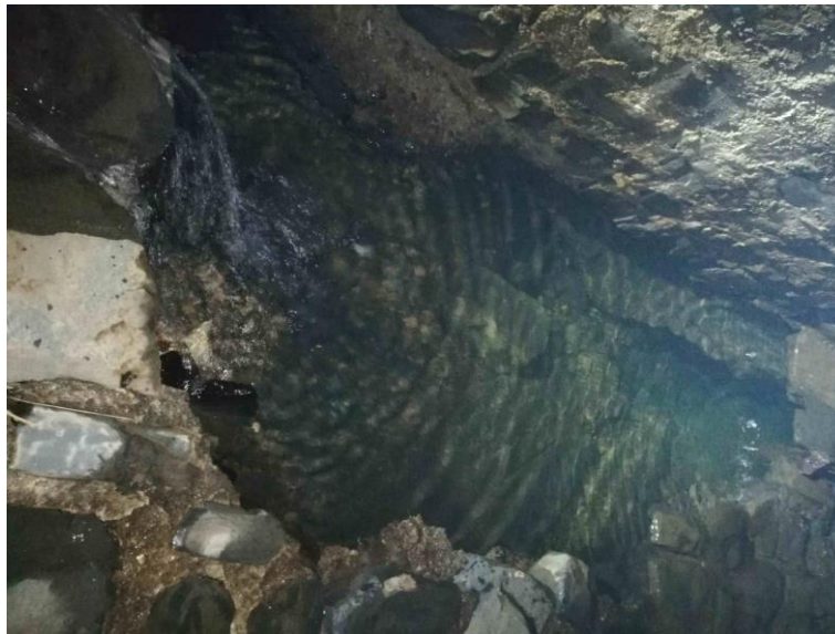
Figura 4: fotografia della cavità presente sul fondo del canale prima del suo riempimento.
