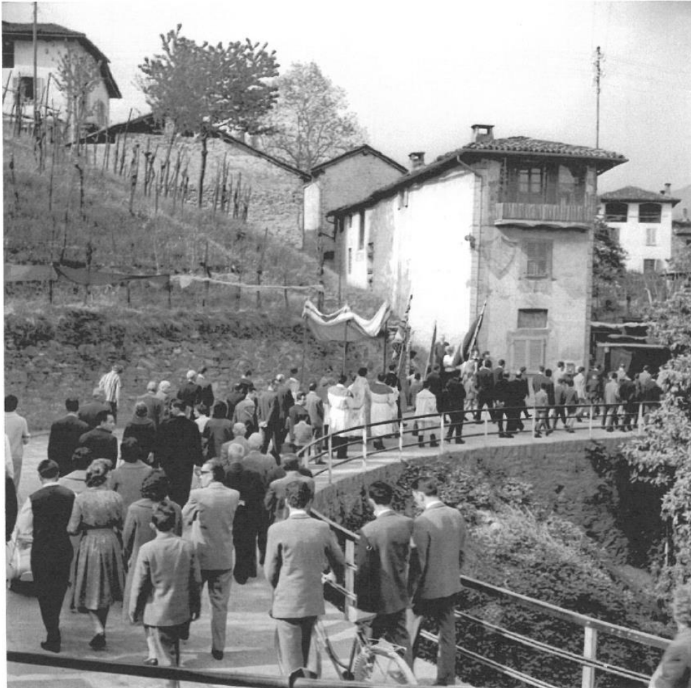
Figura 2: fotografia storica che cattura una processione sul ponte del riale Bornago.
