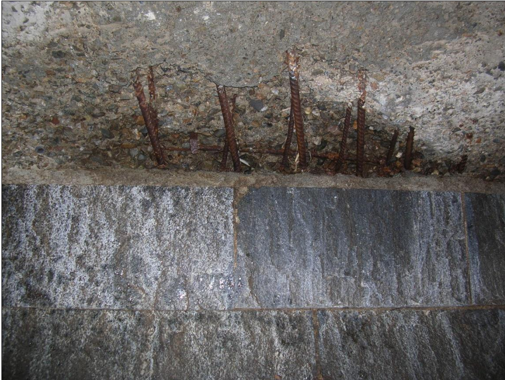
Foto 37: d23 – Vista del ferro d'armatura in elevazione.
