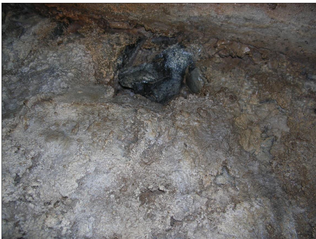
Foto 8: d4/d5 – Rottura sotto la testa (filo soletta) del canale.
