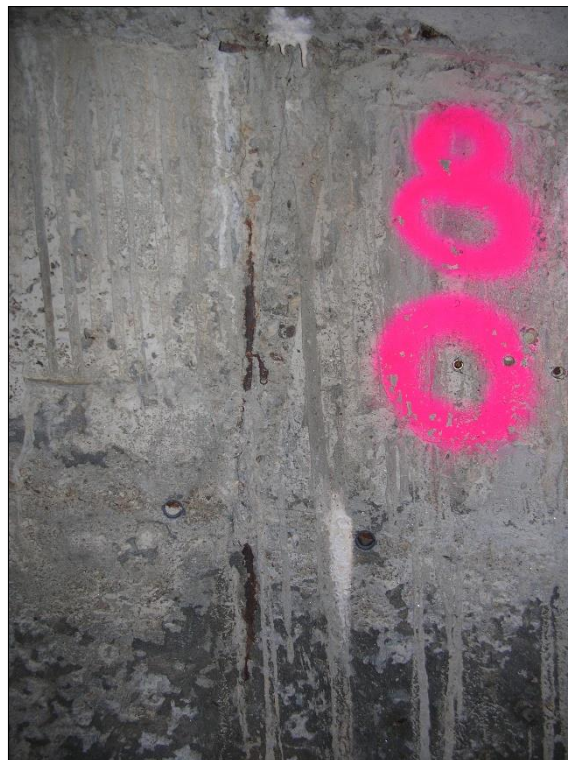
Foto 36: d22 – Vista del ferro d'armatura in elevazione.
