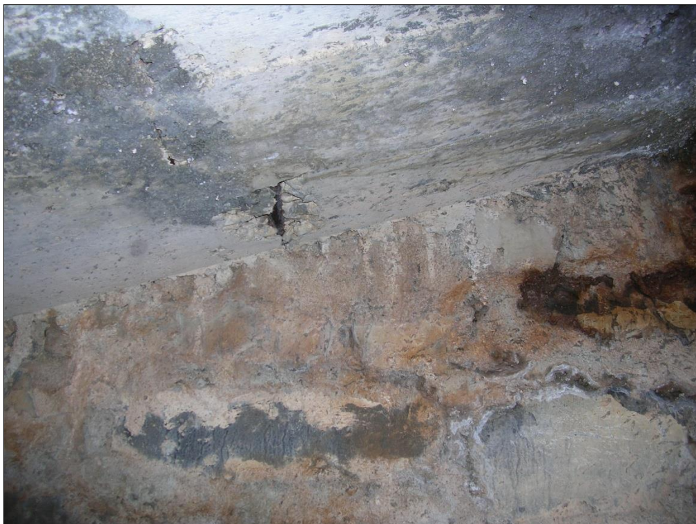
Foto 23: d16 – Rotture sul filo soletta.
