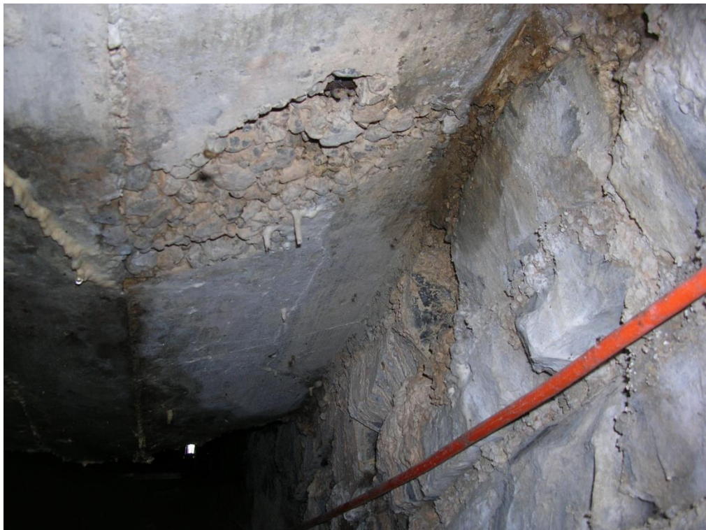
Foto 12: d8 – Rottura sul filo soletta.
