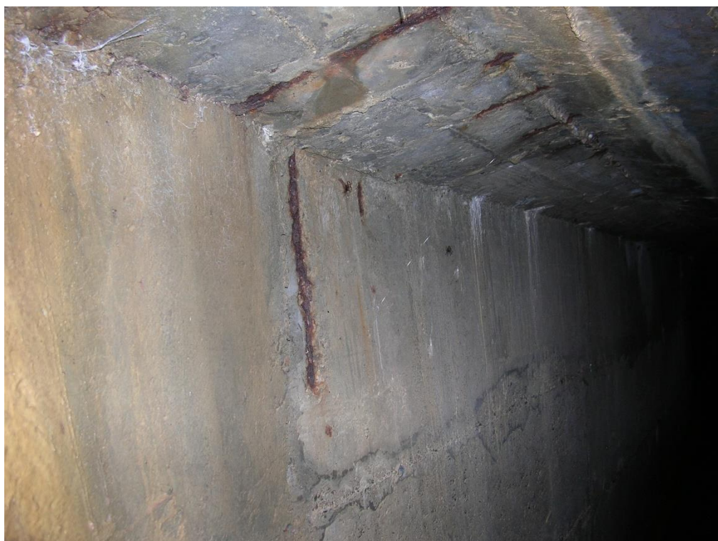
Foto 40: d26 – Vista del ferro d'armatura sul filo soletta + elevazione.
