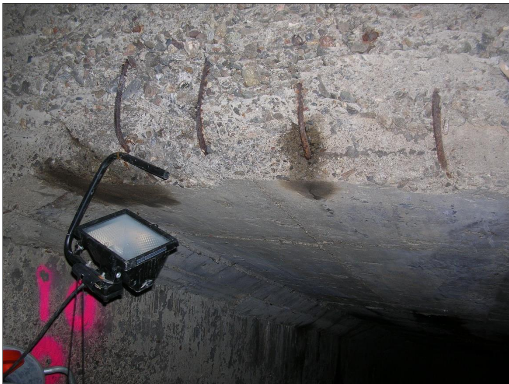
Foto 31: d19 – Vista del ferro d'armatura sulla soletta.
