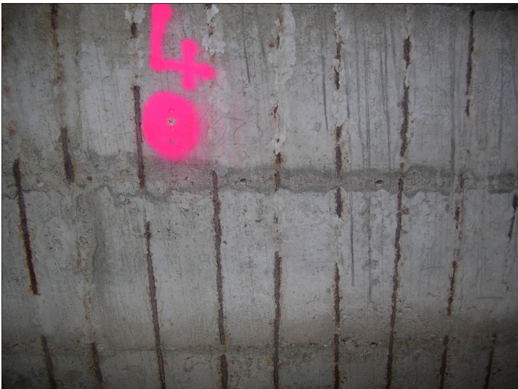
Foto 48: d29/d30 – Vista del ferro d'armatura lungo l'intera sezione.
