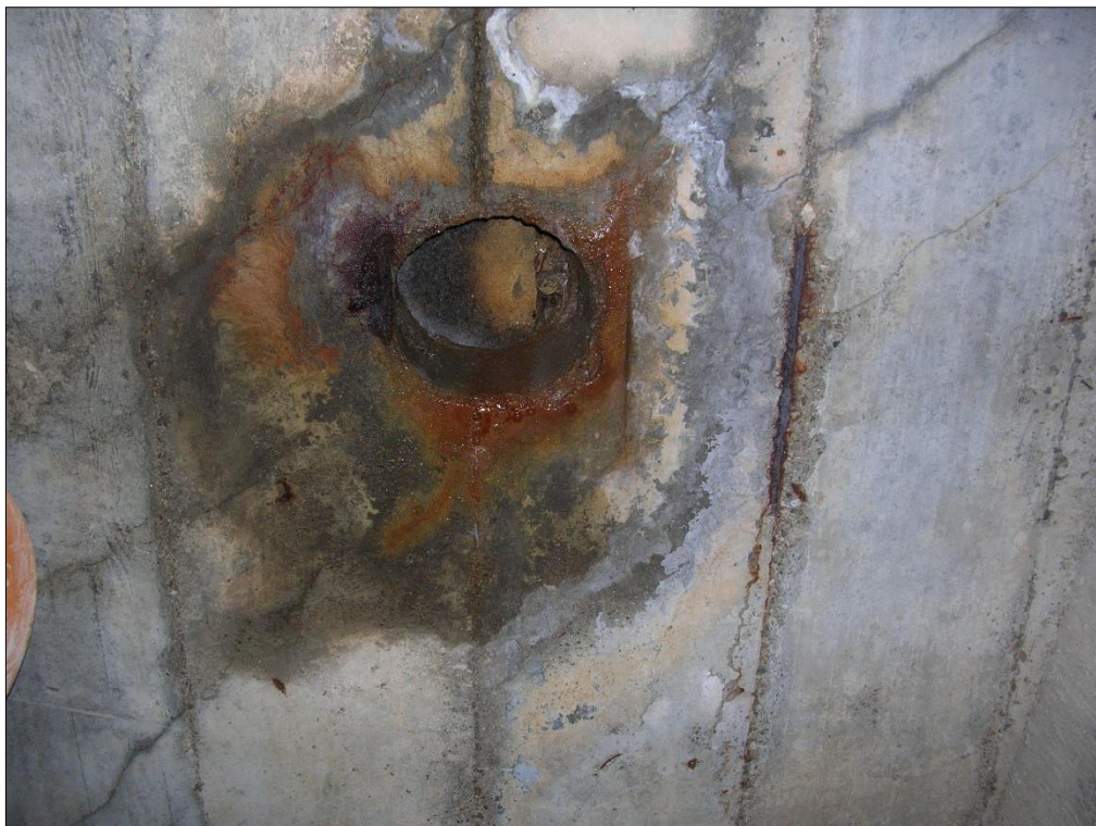
Foto 29: d19 – Vista dell'estrazione di un carotaggio in soletta.
