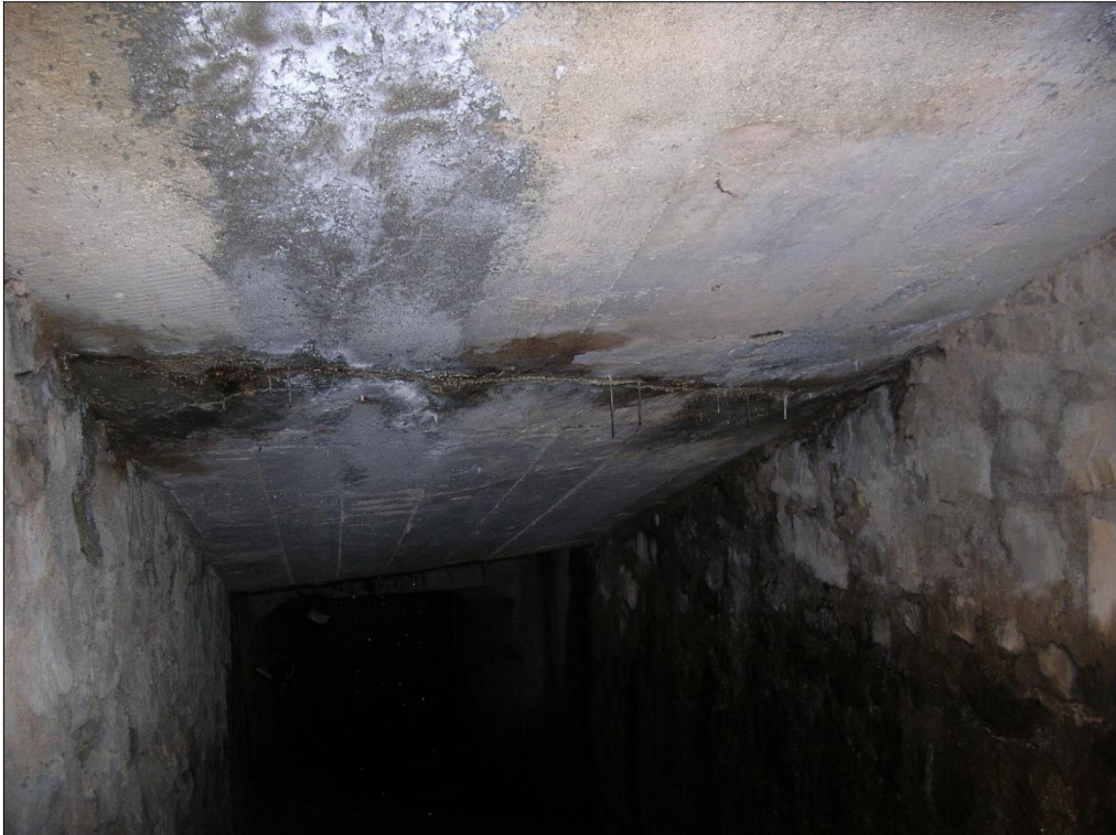
Foto 27: d18 – Rotture sul filo soletta.
