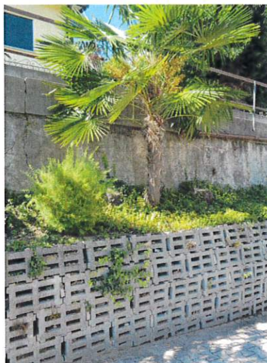
Figura 1: muro con terrapieno in grigliati esistente
