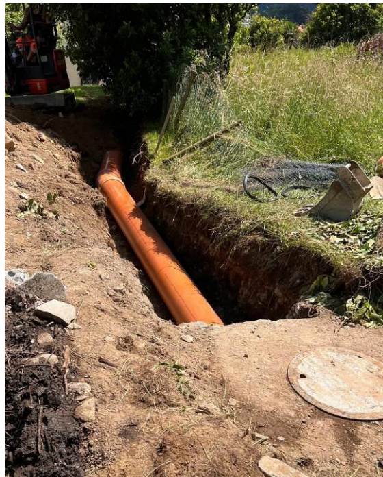
Fotografia 20 e 21: tubazione provvisoria posata da impresa di costruzioni
