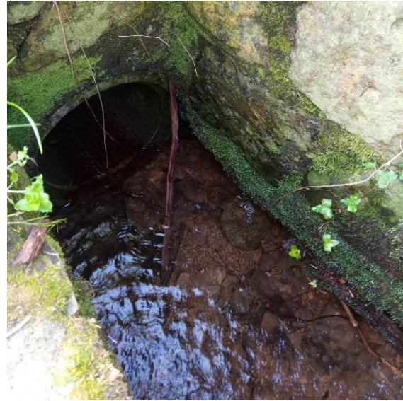
Fotografia 15 e 16: vista dell'alveo a cielo aperto a valle dello stagno e dell'imbocco del tubo in cemento DN400
