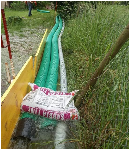
Fotografia 19: tubazioni provvisorie posate da operai comunali
