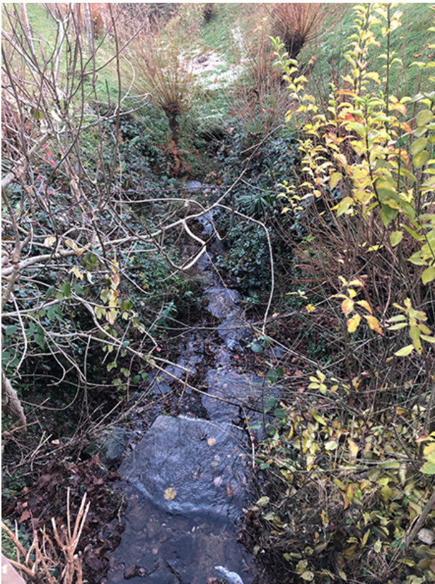
Immagine 17. Ultimo tratto a cielo aperto in corrispondenza del mapp. 195.
