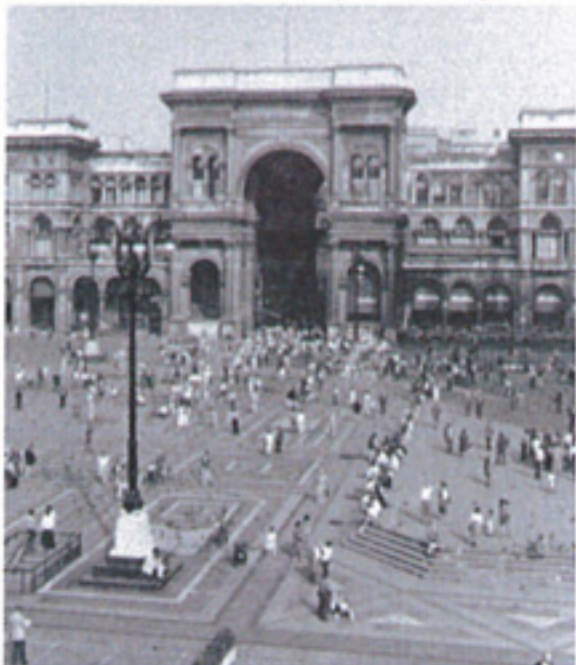
GALLERIA MENGONI, MILANO, 1861.
